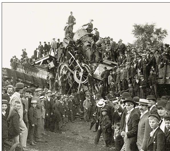
Obr. 7.1 Příklad 7.1. Následky srážky lokomotiv v roce 1896
